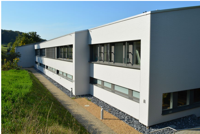
Schulhaus Obermumpf, Energetische Sanierung Kostenvoranschlag: 1'740'000 Bauabrechnung: 1'695'000
